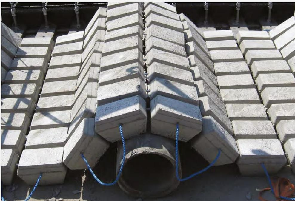
☞ Photographie 1 : Exemple d'une canalisation lestée par un matelas en blocs béton articulés (ACBM)<sup>4</sup>
