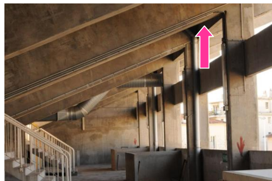
Vue du 2 ème étage où se trouve la fissure accueillant les chauves-souris (indiquée par la flèche)
