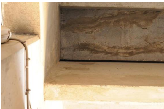
Vue d'une partie de la fissure verticale accueillant les chauves-souris
