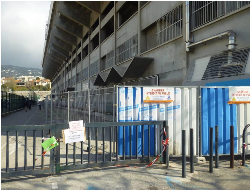
Illustration des aménagements de sécurisation de l'édifice menaçant ruine (Photo : Ville de Nice)
