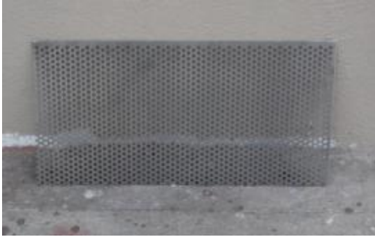
Obturation avec tôles en acier micro-perforées à l'extérieur
