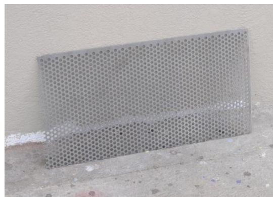
Tôle micro-perforée utilisée pour obturer les fissures Photo prise sur site : Vincent Carrère
