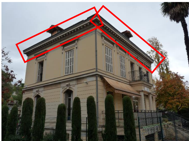
Emplacements presentis pour l'installation de nids et nichoirs artificiels sur les bâtiments « La Source » © M. Gendrot
