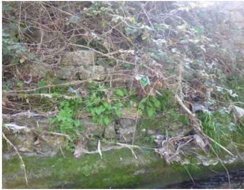
Consoude bulbeuse sur des gabions (installés depuis les années 1960) - © P. AUDA – AGIR écologique
