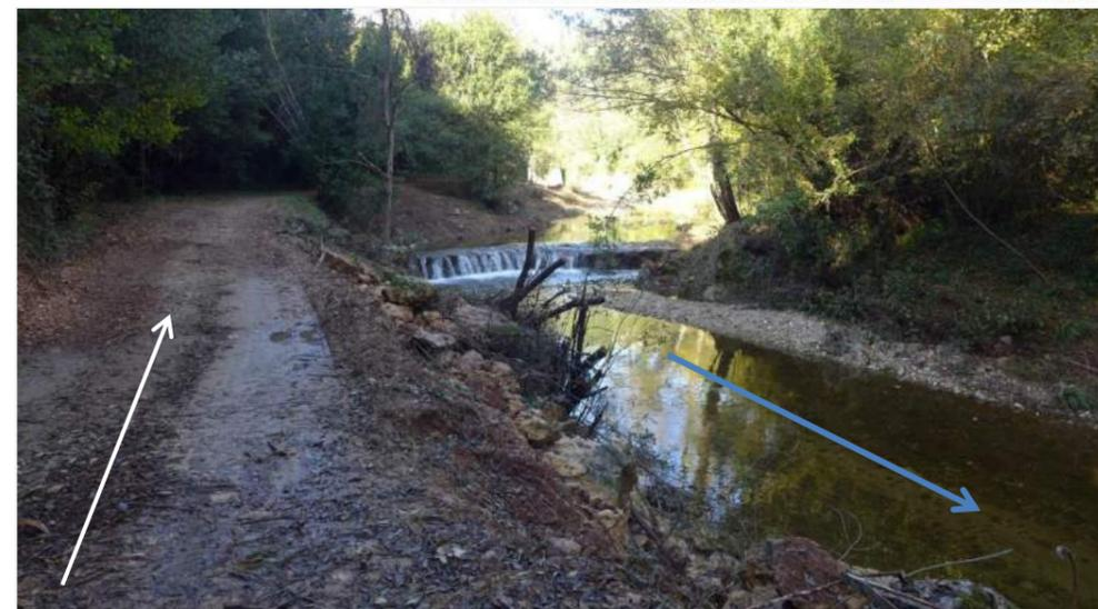
L'accès à la zone de chantier va nécessiter la mise en œuvre d'un passage à gué **temporaire** au droit du poste de relevage. Il est rendu nécessaire par la présence d'un parement rocheux en rive gauche qui oblige à traverser la rivière pour rejoindre la rive opposée.
