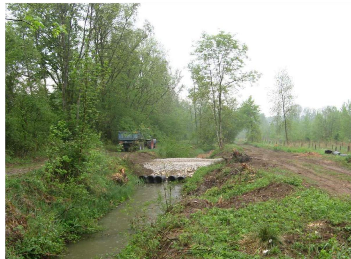
Figure 31. Illustration du passage à gué temporaire établi dans le cadre d'un chantier similaire
