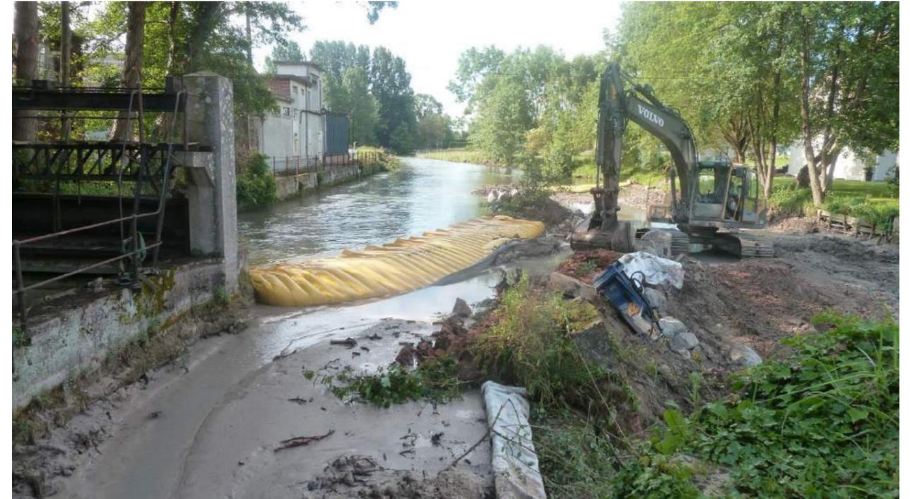
Figure 49. Illustration du dispositif de type Watergate permettant de réaliser une mise au sec des zones de travaux
