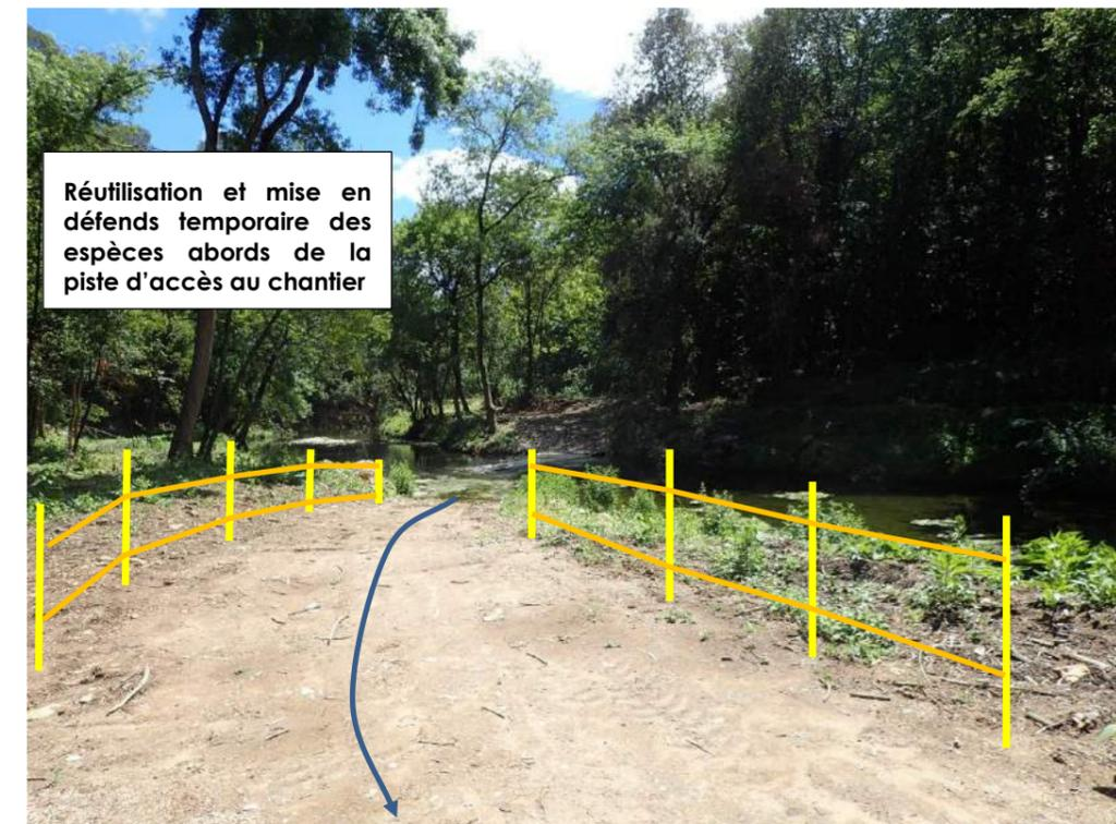
Figure 52. Illustration de la mise en défends en bordure de la piste d'accès au chantier
