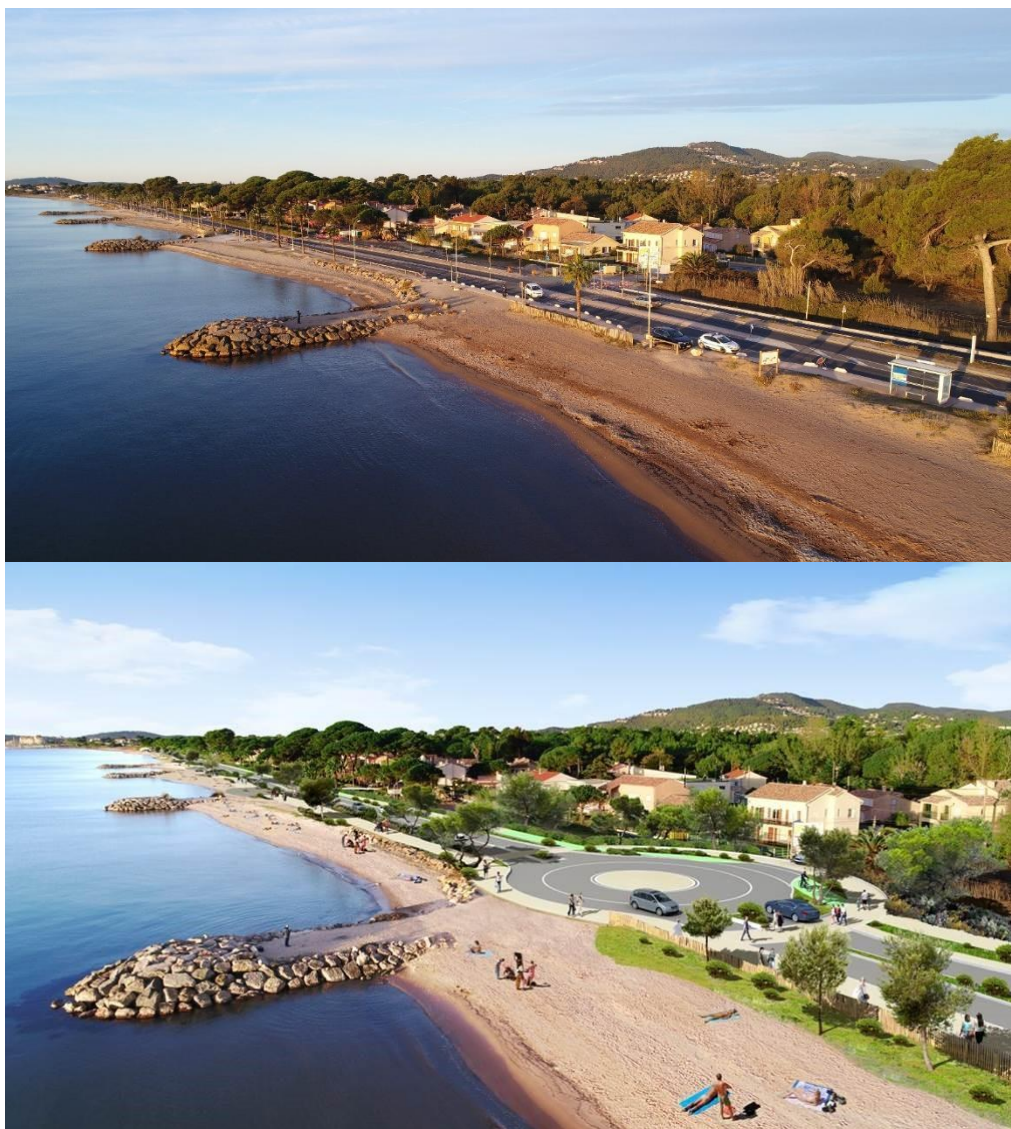
Figure 5 : Aperçu avant et après création du giratoire, Nord du boulevard. ©Guillermin
