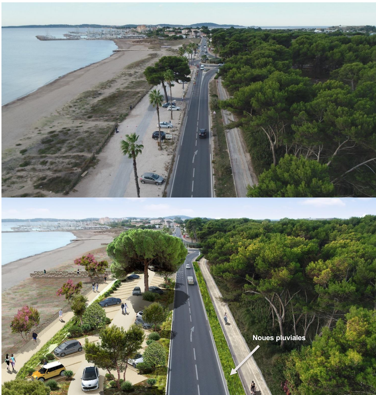
Figure 6 : Aperçu avant et après, parking sud et noues pluviales
