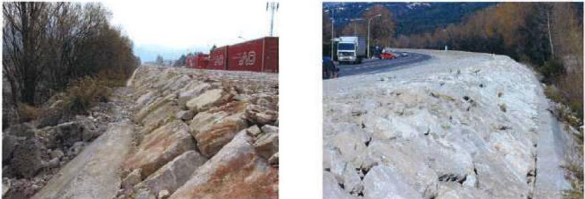
Figure 5 : Travaux de rehausse de la digue de Z.I. Carros en 2003
