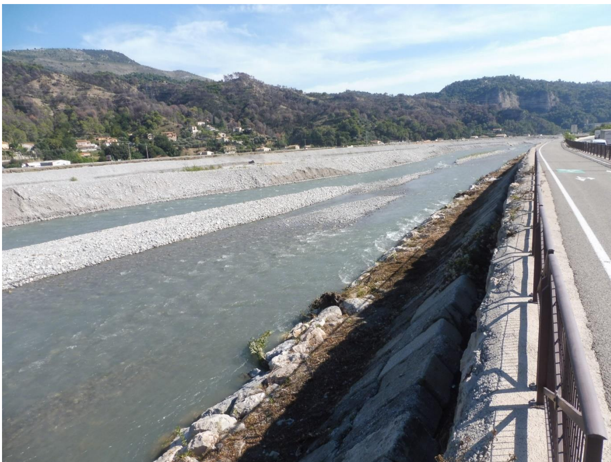
Aspect du lit du Var au niveau du secteur 1 des travaux
