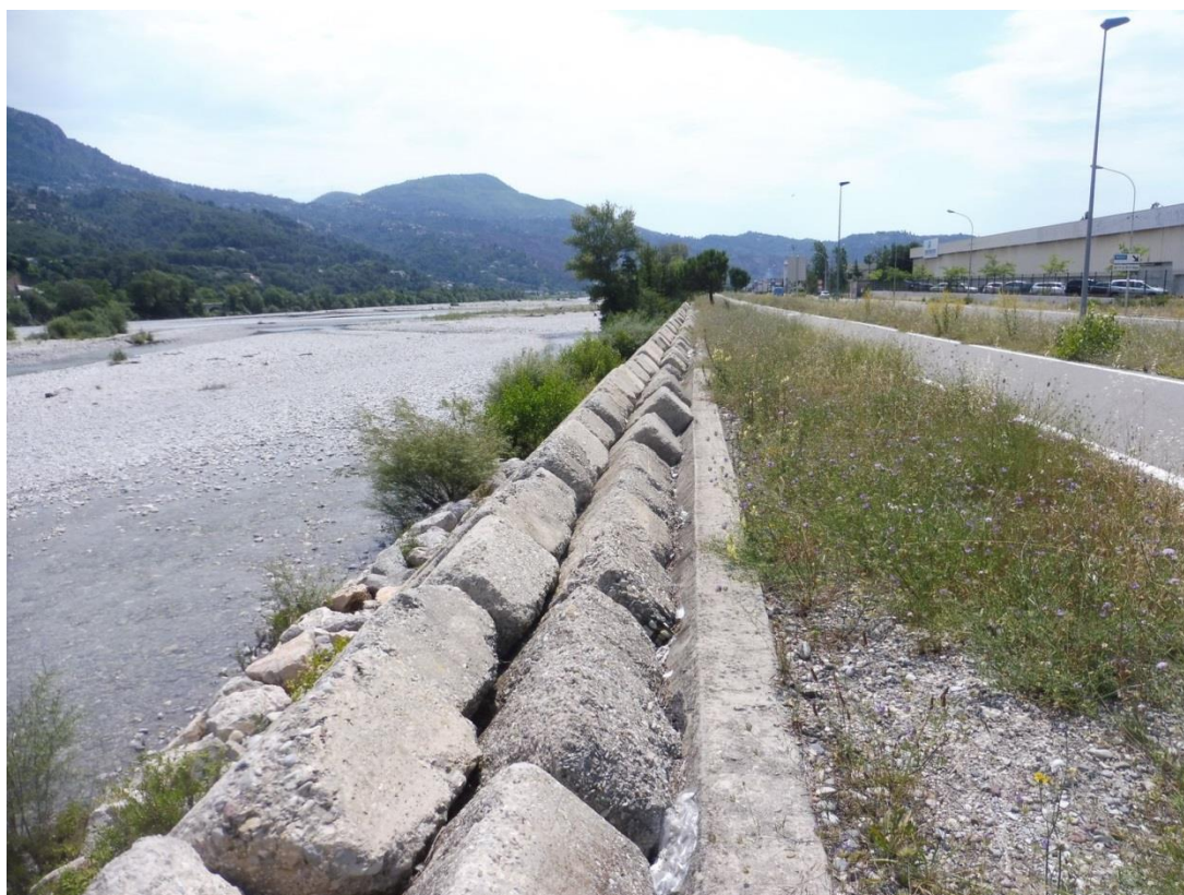
Configuration de berge avec bande enherbée en crête de digue
