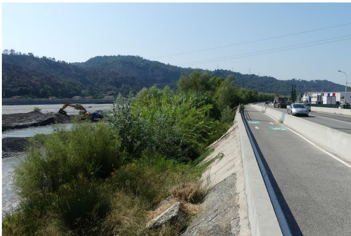
Configuration de berge avec végétation sur perré sans sucres (secteur 9)
