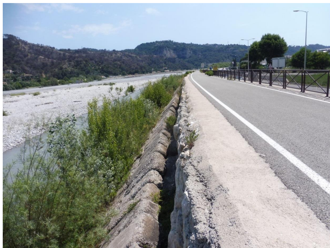
Configuration de berge avec végétation en pied de digue
