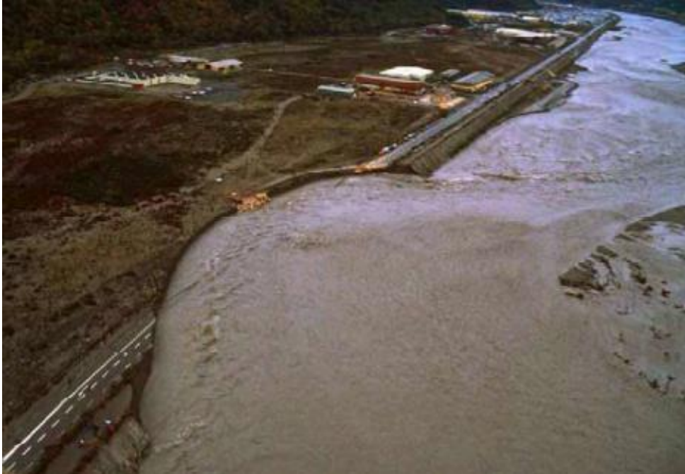
Figure 4 : Brèche digue ZI Carros – Le Broc (crue de 1982)
