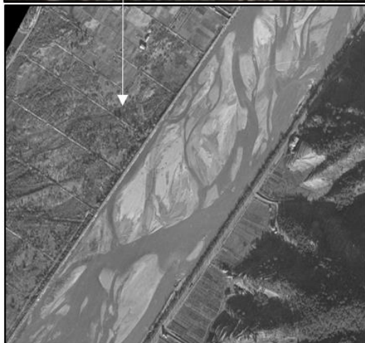
Faciès méditerranéen d'origine artificielle : système chenalisé situé à l'aval du pont de la Manda (1943) avant l'existence des seuils et des travaux d'extraction d'alluvions
