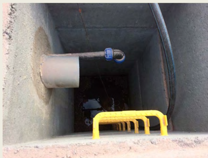
Intérieur du puisard avec collecte et renvoi des lixiviats des S1, 2 et 3 au bassin tampon
