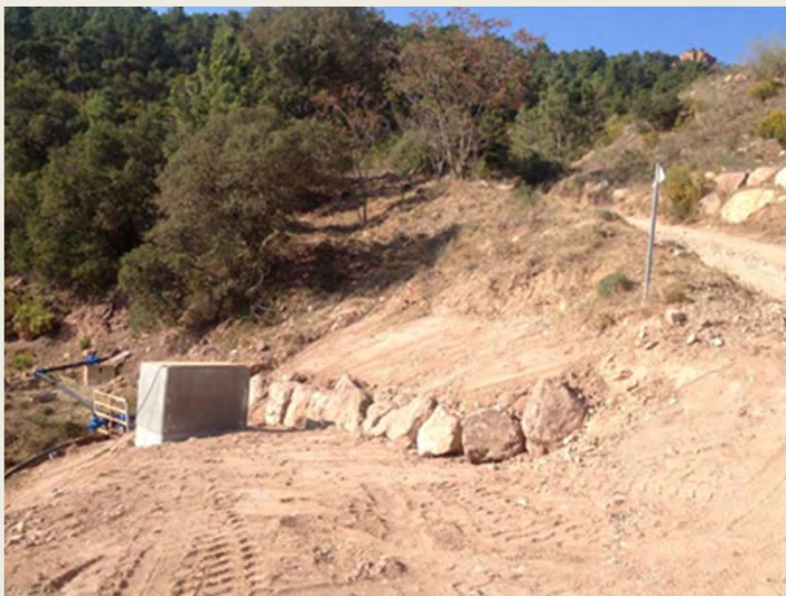
Puisard de captage des eaux parasites Septembre 2017
