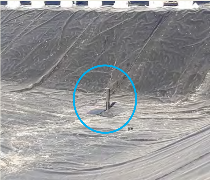
Puits de pompage
