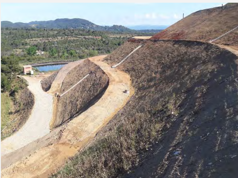
Couverture du site 4 : zone finalisée avant revégétalisation au niveau du site 4, avec descentes d'eau
