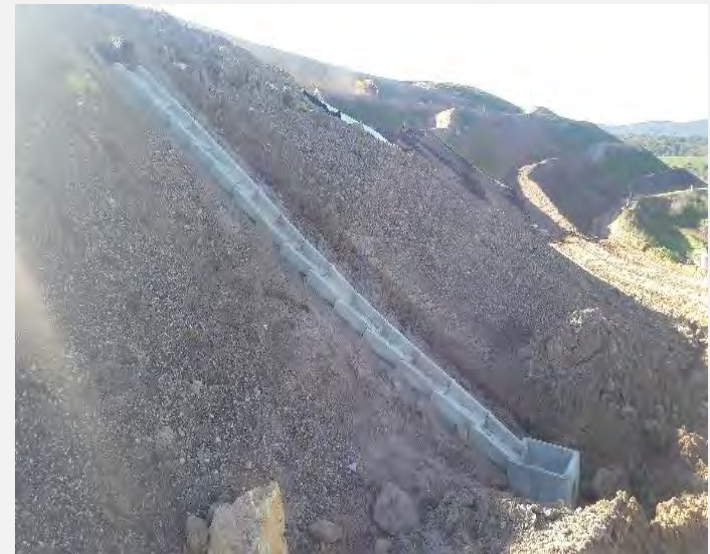
Couverture du site 4 : aménagement de descentes d'eaux bétonnées
