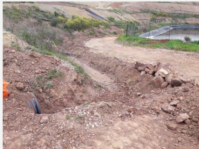
Réalisation de tranchées pour améliorer la gestion des eaux
