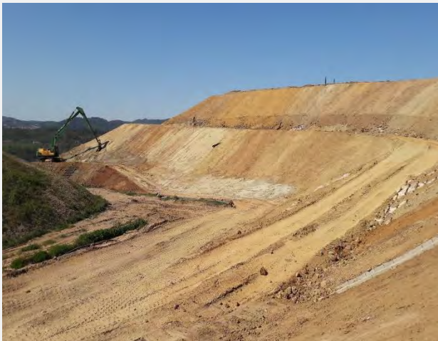
Couverture du site 4 : zone de travaux finalisée avant aménagement des descentes d'eau
