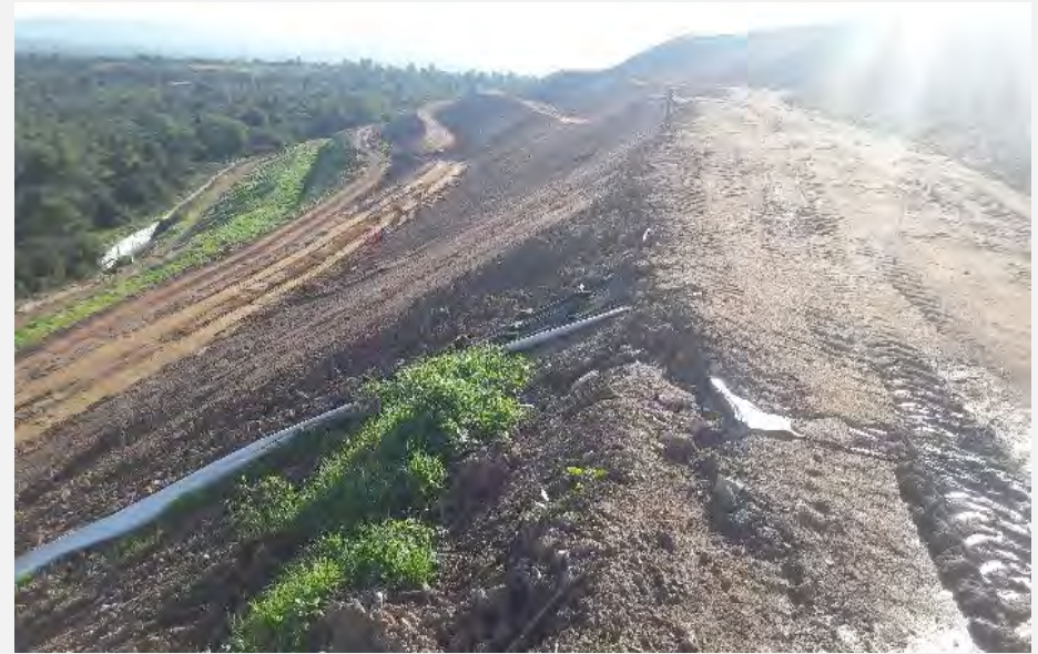
Couverture du site 4 : zone finalisée avant aménagement des descentes d'eau
