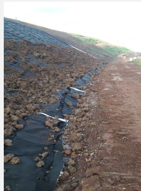
Couverture du site 4 : pose des géotextiles d'étanchéité et de drainage
