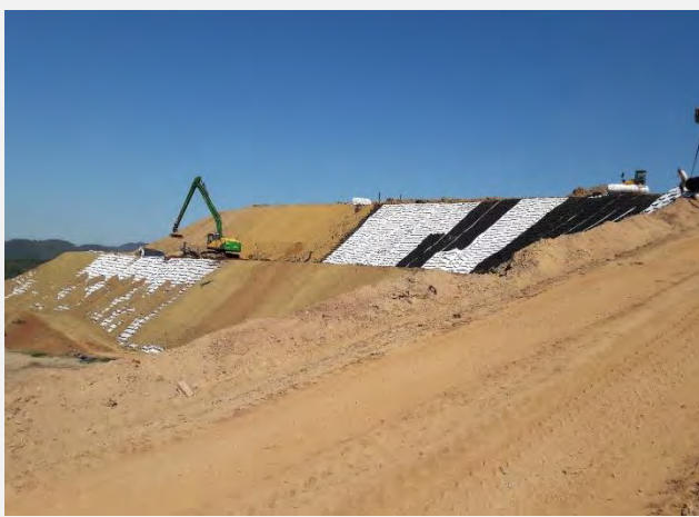
Couverture du site 4 : pose de géotextiles d'étanchéité, de drainage puis accroche terre et recouvrement de terre
