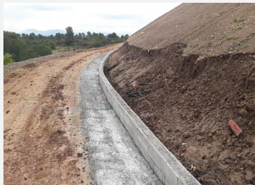
Couverture du site 4 : réalisation de fossés de récupération des eaux pluviales en béton
