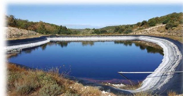
Bassin rétention des lixiviats
