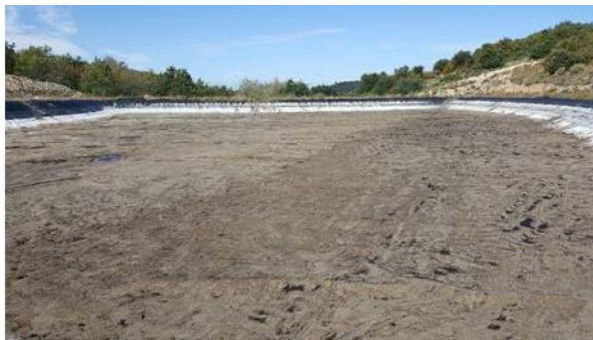
Bassin des lixiviats (2 octobre)
