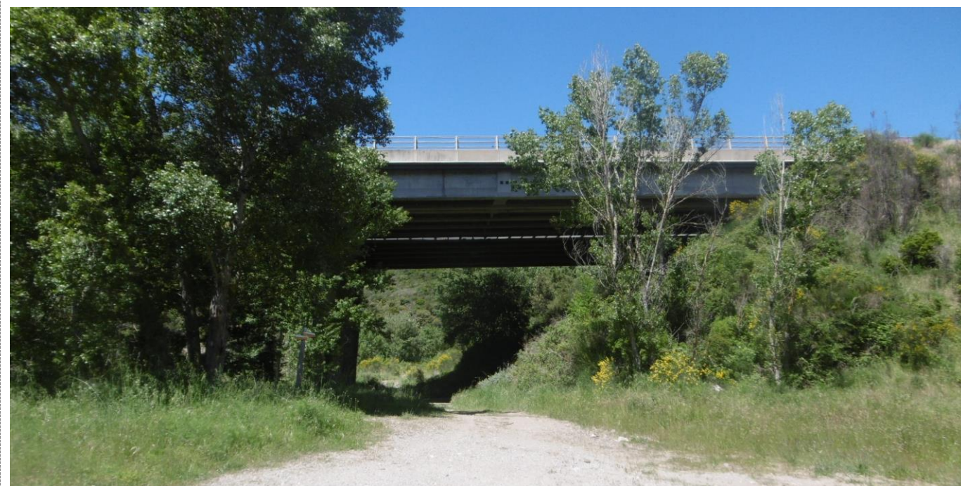
Aperçus du viaduc du Reyran
