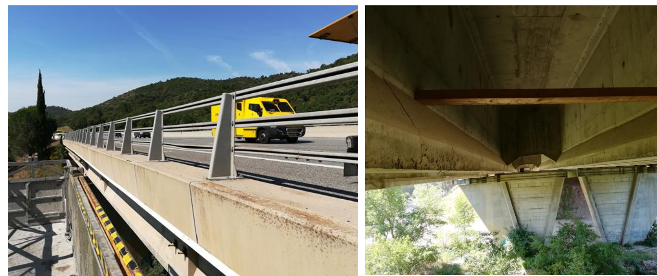
Figure 3 : Viaduc du Reyran (Photos : J.C. Delattre et M. Faure / NATURALIA)
