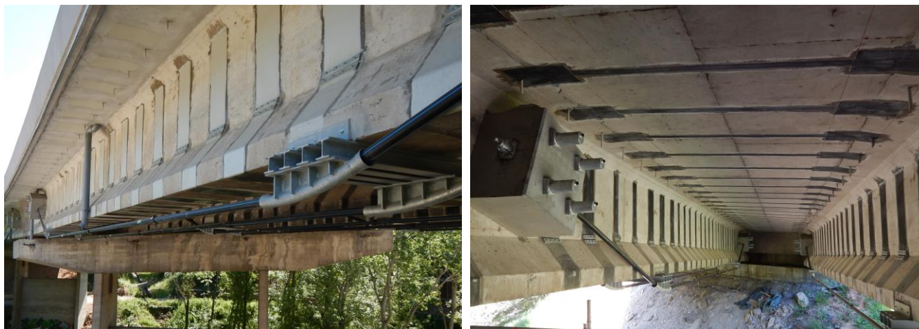
Figure 14 : Illustration de travaux similaires de renforcement du VIPP 244 (Photos transmises par DIADES)
