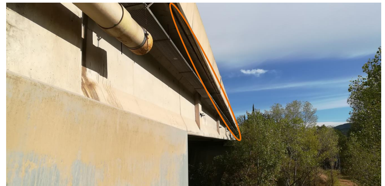
Figure 20 : Illustrations des zones favorables prospectées avec le joint de dilatation en haut à gauche, un drain (ou gargouille) en haut à droite et l'une des corniches en bas (Photos : M. Faure et L. Roussel / NATURALIA)
