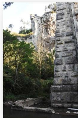
*Aqueduc de Roquefavour, disjoints dans une pile de pont, falaises et arbres remarquables à proximité de l'aqueduc © R. Colombo- Asellia*
