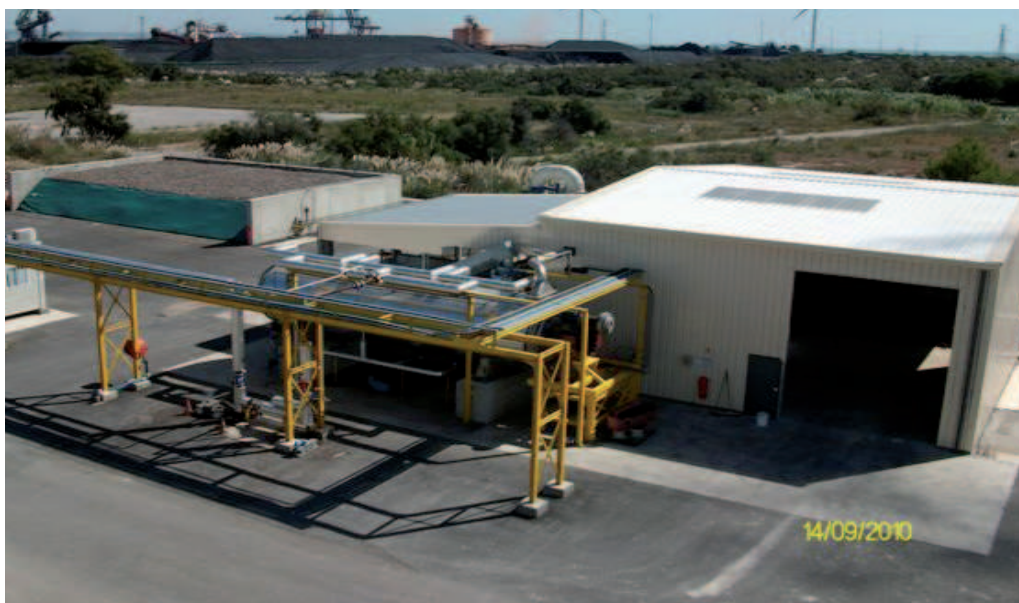
Unité de séchage de boue - SARP INDUSTRIE Fos-sur-Mer
