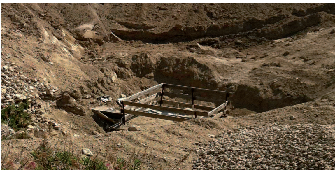
RETIA confinement de terres polluées - Site de l'Estaque Marseille mai 2011
