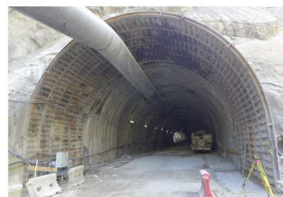
Percement du tunnel de Chabrières
