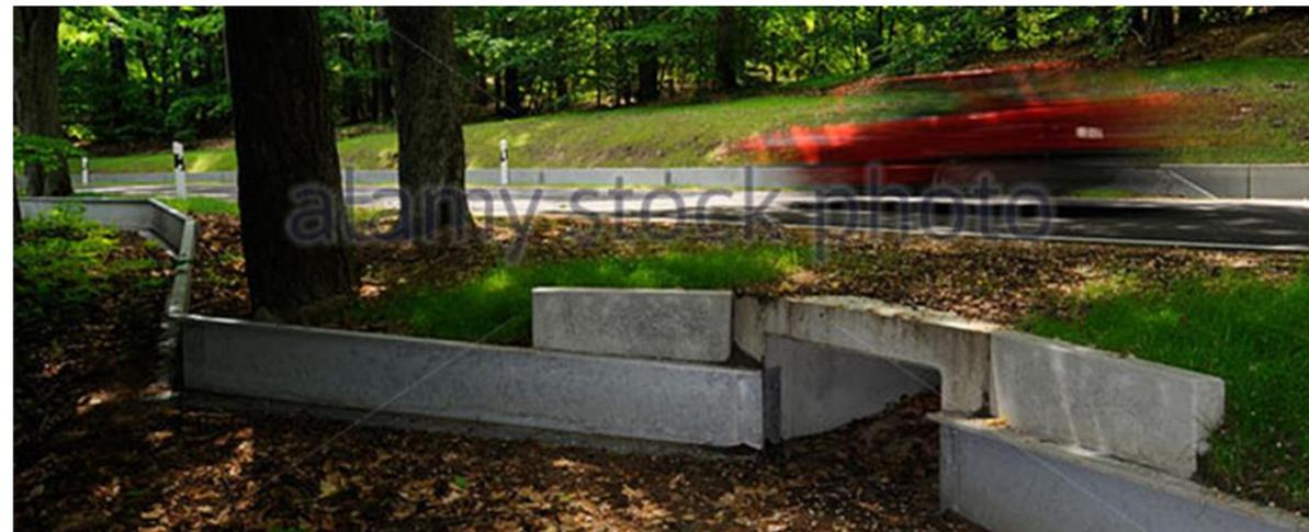
Figure 23 : Exemple de « clôture pleine » permettant de guider la Faune vers un passage inférieur (ici franchissement par le dalot et les abords de la route des Caves à l'Ouest). Source : Alamy
