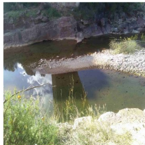
Station Le Muy sur l'Endre (83) (Source : DREAL PACA)
