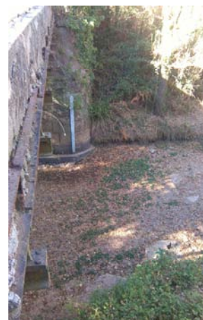
Station Pierrefeu sur le Réal Collobrier en assec (83) (Source : DREAL PACA)
