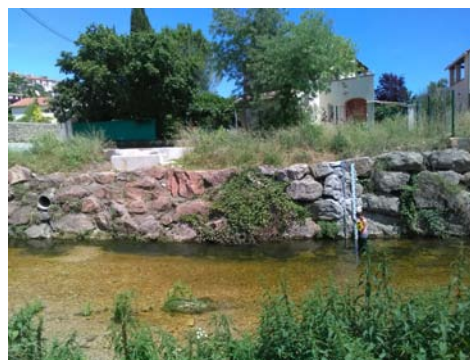
Nouvelle station de la Brague à BIOT (06) (Source : DREAL PACA)
