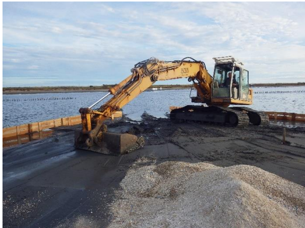
Figure 2-1 : Création de l'îlot du bassin ouest sur l'ancien salin de Villeroy
