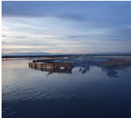
Figure 2-2 : Création de l'îlot du bassin ouest sur l'ancien salin de Villeroy
