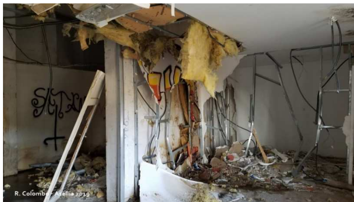
Intérieur des silos à l'abandon et présentant des risques d'effondrement
