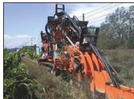
Création des tranchées de raccordement
