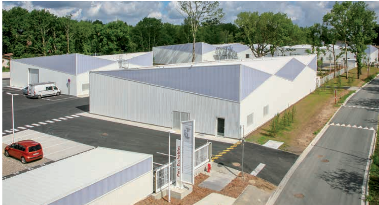
Parc Ecchobloc, Le Taillan-Médoc (33)
