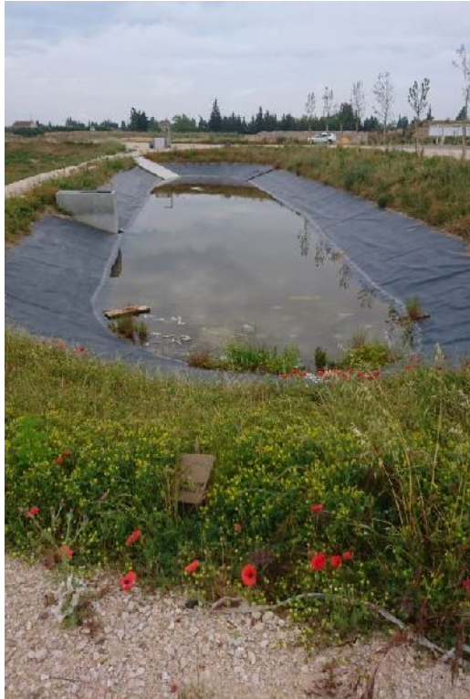
Figure 13 : Bassin de rétention sur le site d'étude
