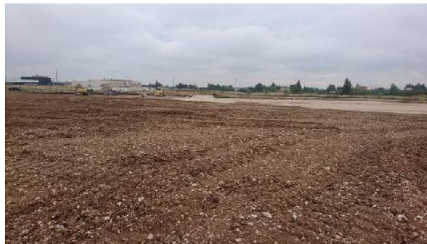
Figure 14 : Sol mis à nu en amont du terrassement
