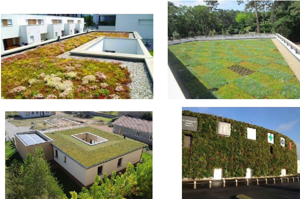
Figure 24 : Toitures et façades végétalisées
