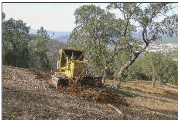
Ouverture d'une piste de desserte dans les Maures (83) L'impact sur les habitats est localement très important. Ici, c'est un habitat banal de maquis à Erica arborea et l'incidence environnementale est mineure en regard des avantages apportés en terme d'accessibilité et de lutte contre d'éventuels incendies.
