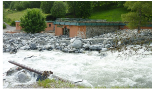
Exemple de dépôts massifs en fond de lit par charriage
