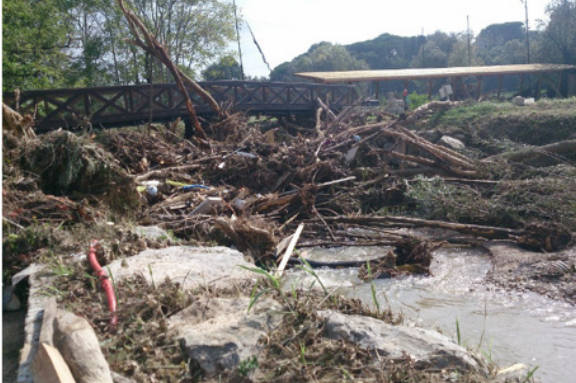
Embâcle au niveau d'une passerelle
