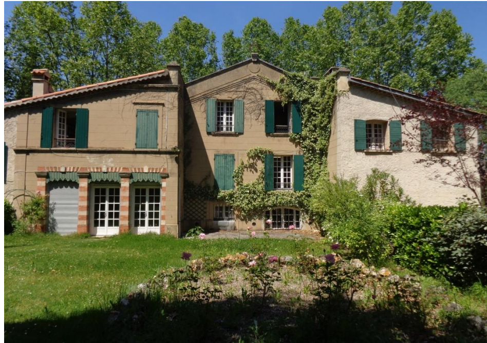
N°1 Vue sur la bastide rénovée dans le cadre du projet -17/05/17 Source : TPF Ingénierie
