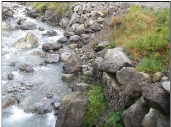
Enrochements libres aux abords de la prise d'eau
