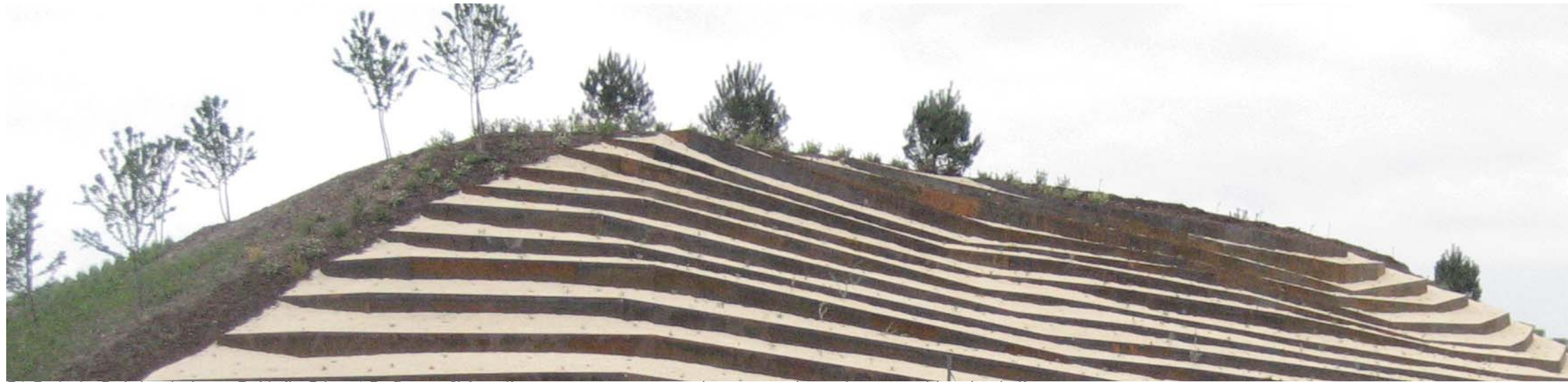
ZAC de la Pointe du Lac, Crèteil - Péna&Peña maîtrise d'œuvre paysage: soutènements corten avant la plantation
