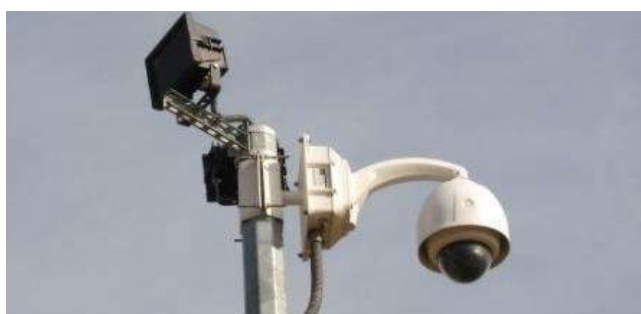
Exemple d'un poteau portant une caméra de surveillance - ECOTER, 2013
