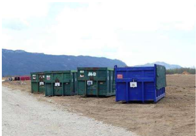
Bennes à déchets sur un chantier de parc photovoltaïque DRYOPTERIS, 2017
