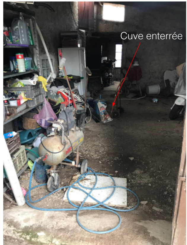
Garage du bâtiment "C" avec cuve à fioul enterrée "2"
