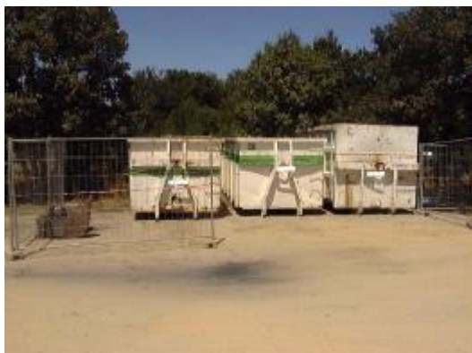
Figure 12 : Exemple de bennes destinées à accueillir les déchets de chantier
