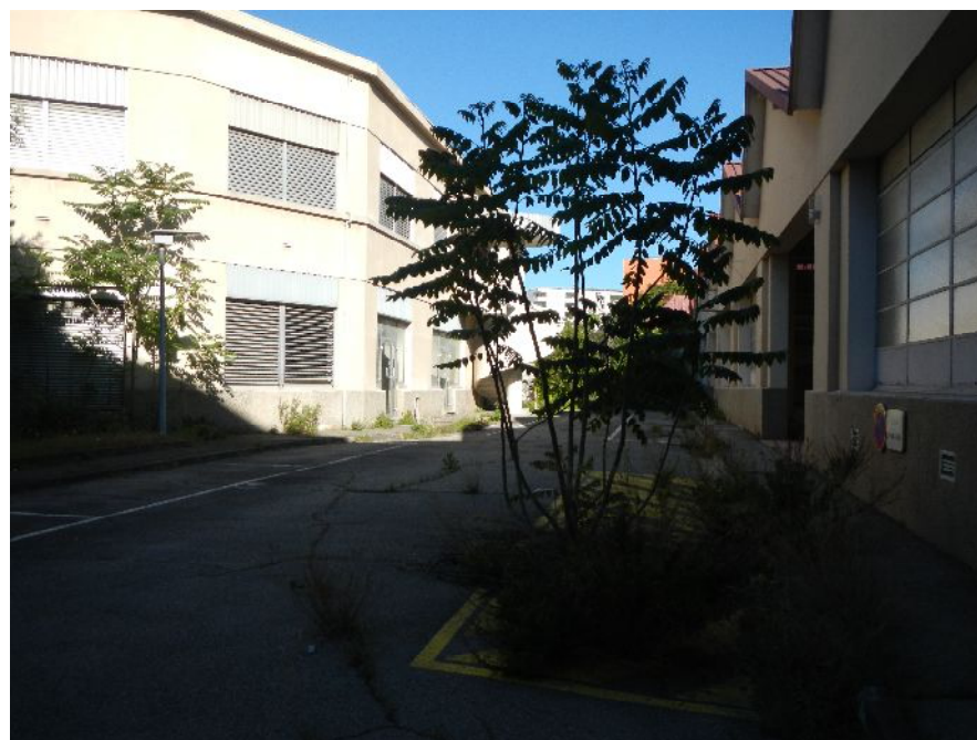
Vue des anciens parkings – zone de stationnement et voirie de circulation
