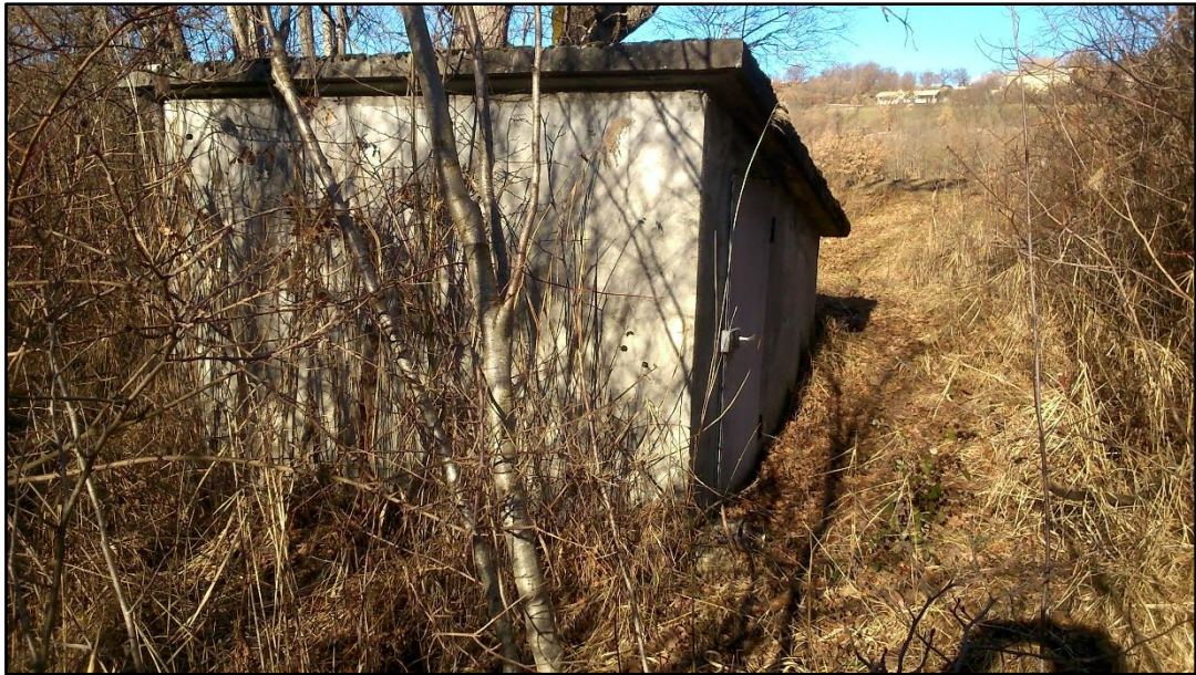
Chambre de captage
