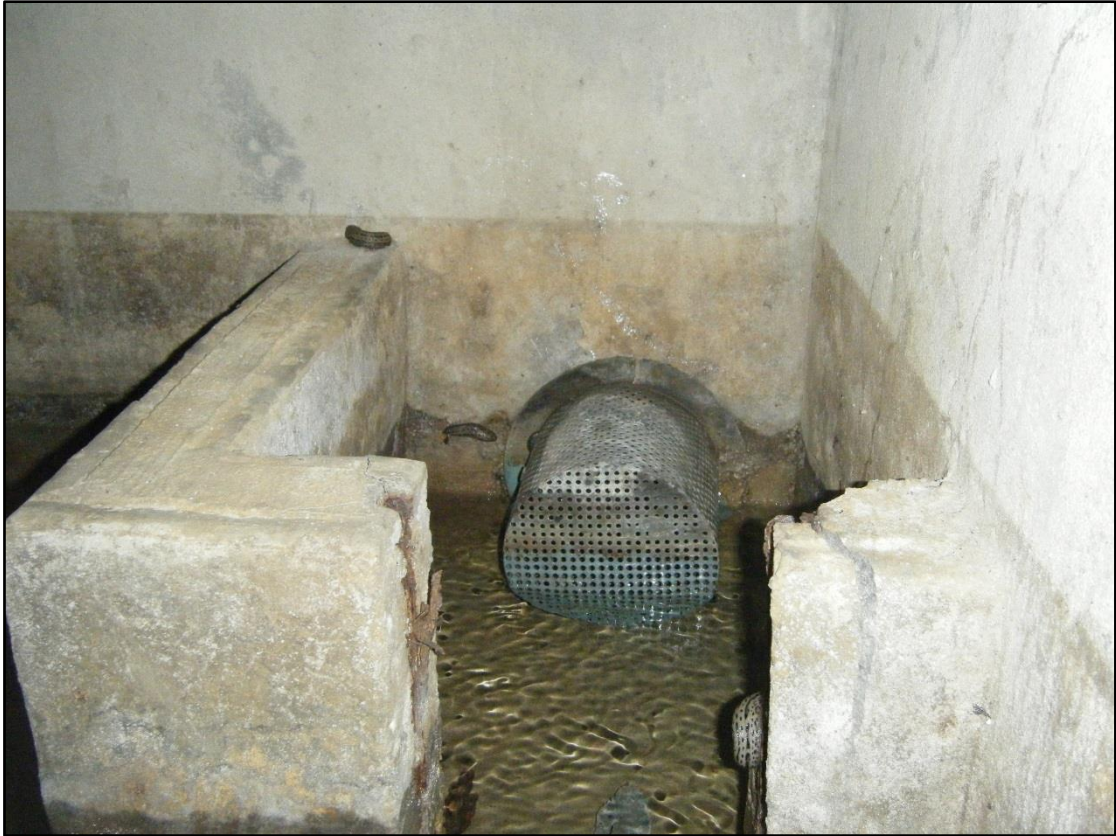
Trop-Plein de la chambre de captage
