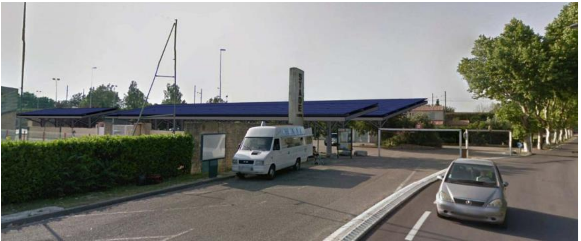
Insertion paysagère depuis la vue n°4 - Projet Nord (environnement proche – Août 2019)
