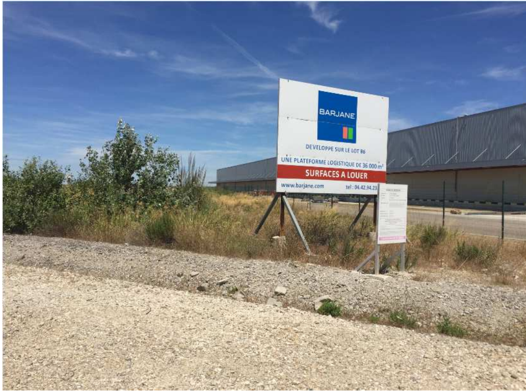
Photo 1 – Vue depuis l'angle Sud-Est (juillet 2017)
