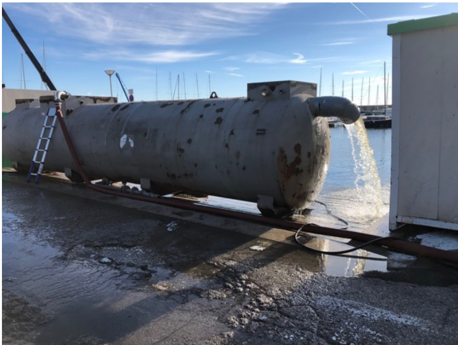
Photographie 2 : Décanteur et rejet dans le port
