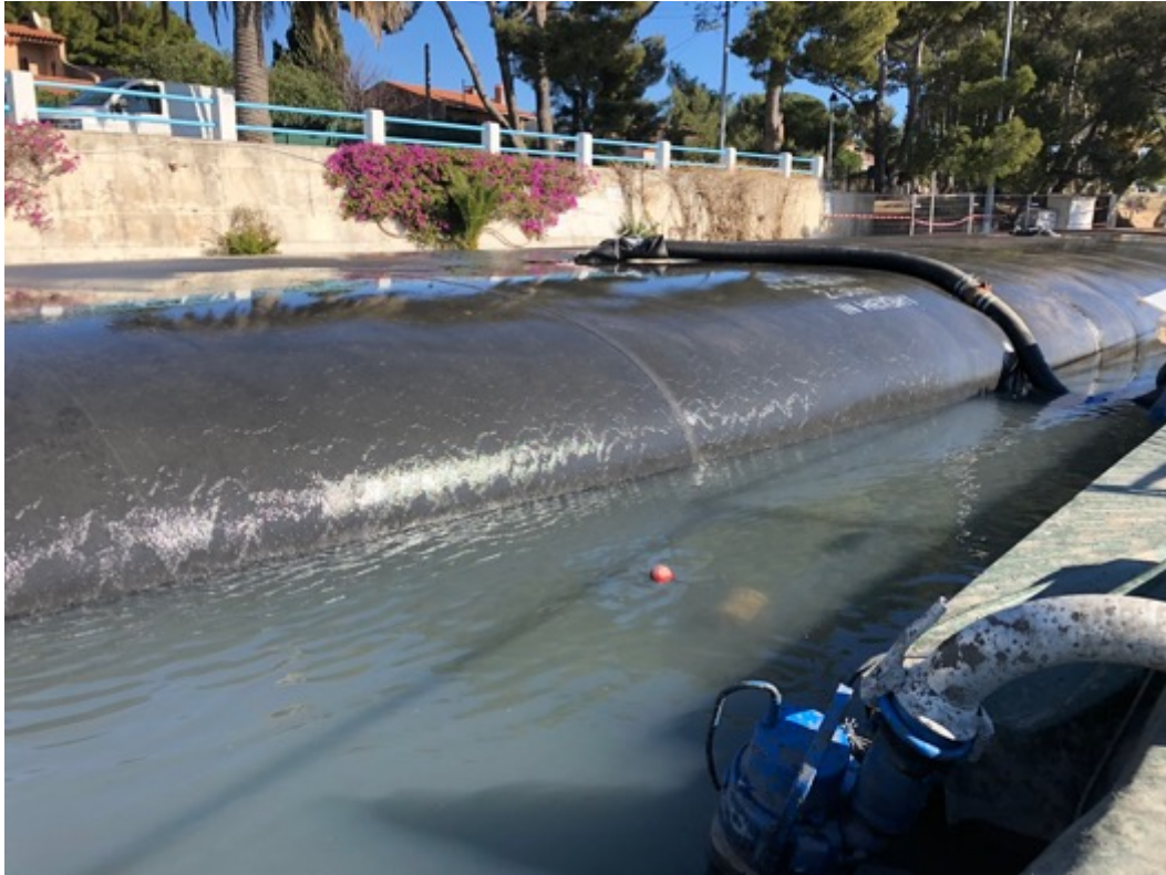
Photographie 1 : Déblais de dragage ressuyés dans un géotube - Port des Salettes à Carqueiranne janvier 2019.
