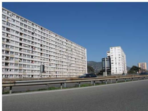
A50 – entrée ouest de Toulon – habitat collectif
