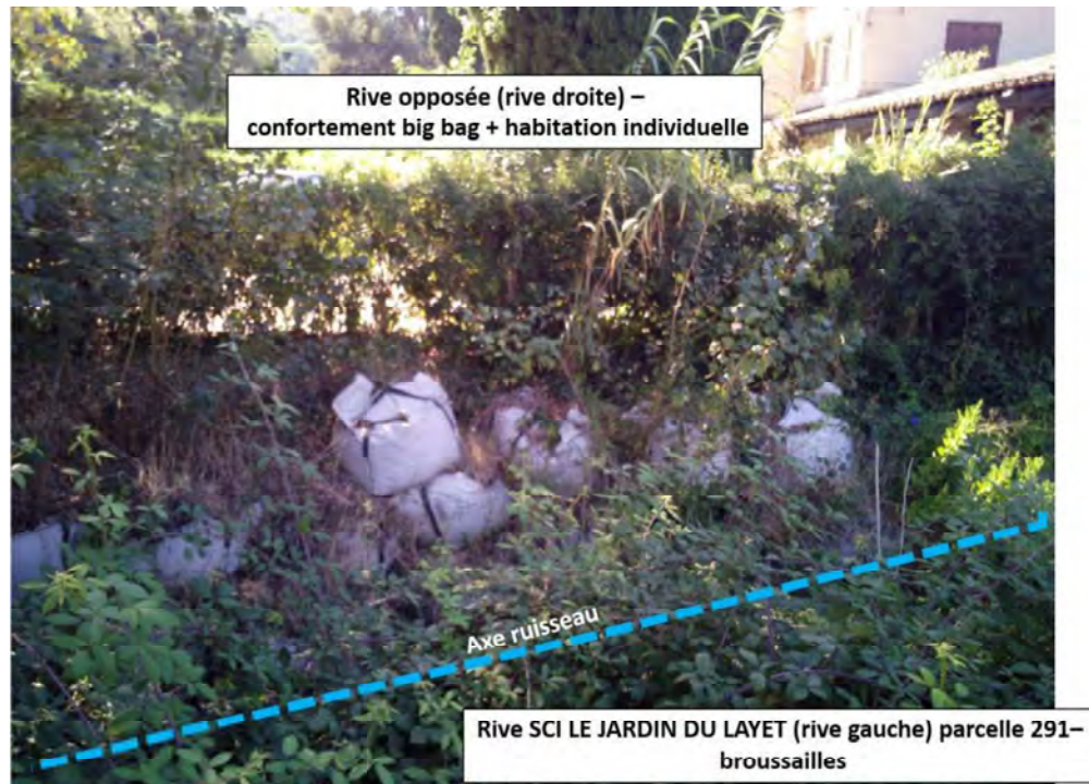
Figure 6 - Ruisseau en bordure de la parcelle 291 – partie basse
