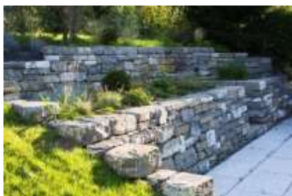
Exemple de murets en pierres sèches favorables aux reptiles.
