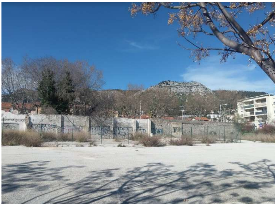
Photo 5 : Mur démoli appartenant à un ancien bâtiment (Even, Mars 2019)
