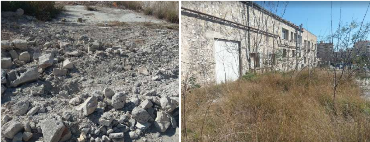
Photo 4 : Gravats présents sur la zone de démolition, et bâtiments désaffectés fortement dégradé situé sur le chantier de démolition. (EVEN, Mars 2019)
