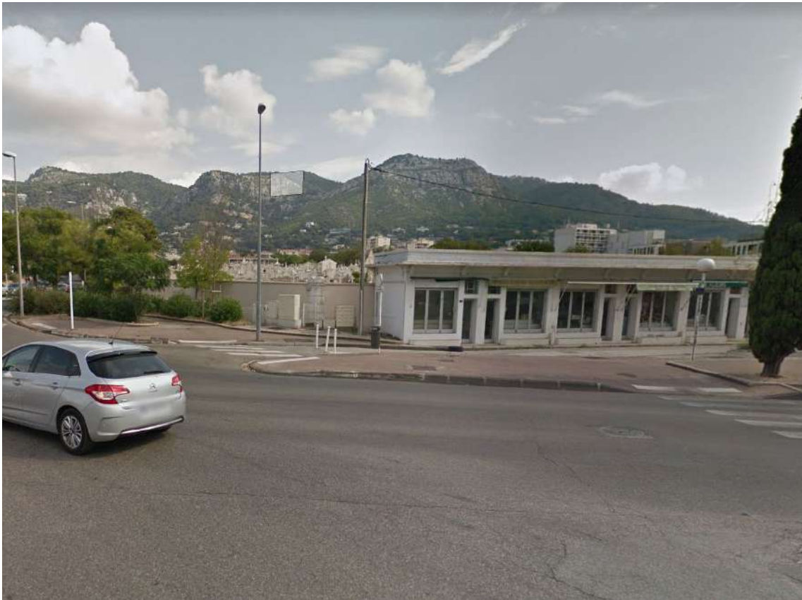
Figure 25 : Vue sur le cimetière depuis le boulevard de la démocratie (Google earth)
