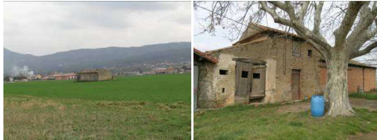
Dépendance agricole isolée - Bâtiment agricole ancien
