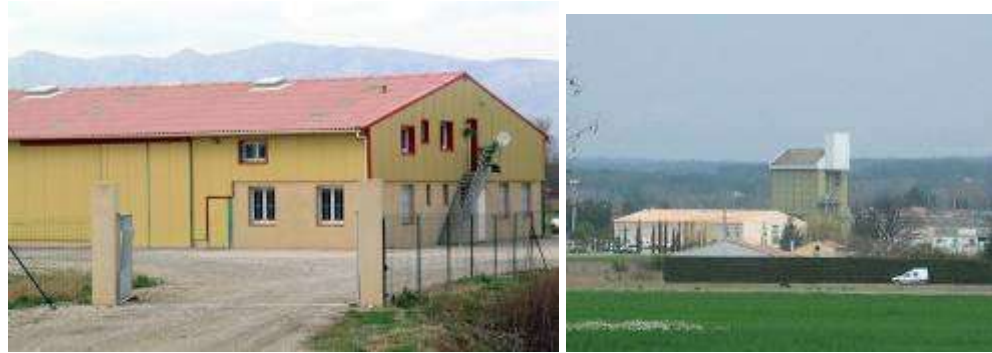
Coopérative agricole d'aromatiques en activité - Ancien silo agricole
