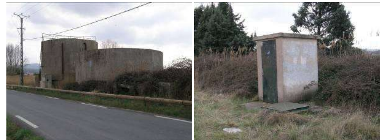
Ancienne station d'épuration - Transformateur
