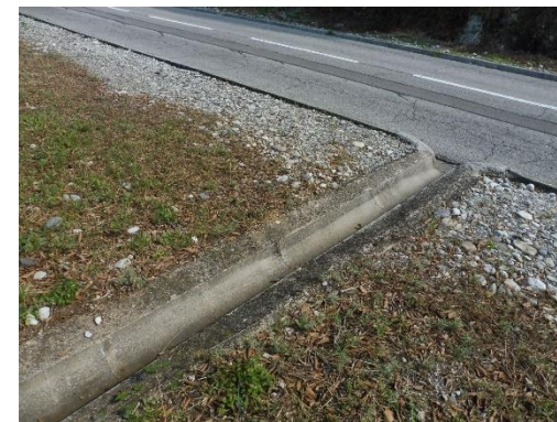
Réseau pluvial des routes dont l'exutoire est orienté sur les pelouses
