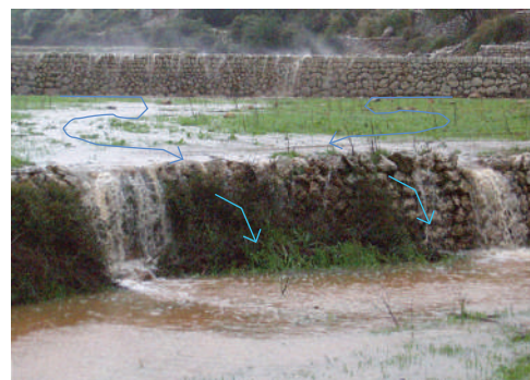
Figure 34 : Les bancaous, une technique de gestion de l'eau pluviale dans la pente Source: Fédération Française des Professionnels de la Pierre Sèche
