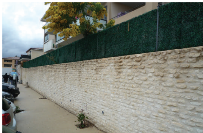
Figure 44 : Le jointoiment des pierres imperméabilise le mur Source:ATM
