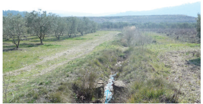
Figure 55 : Fossés d'irrigation issus des surverses du canal de Marseille Source: ATM
