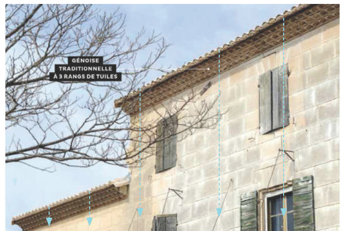
Figure 72 : Technique traditionnelle des génoises ou les débords de toitures en tuiles canals mettent à distance l'eau des façades Source: CAUE 13
