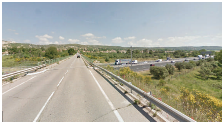
Figure 21 : Aujourd'hui, le profil routier des ponts construits au-dessus de l'autoroute A8 ne favorise pas les promenades piétonnes vers la rivière Source: Google map
