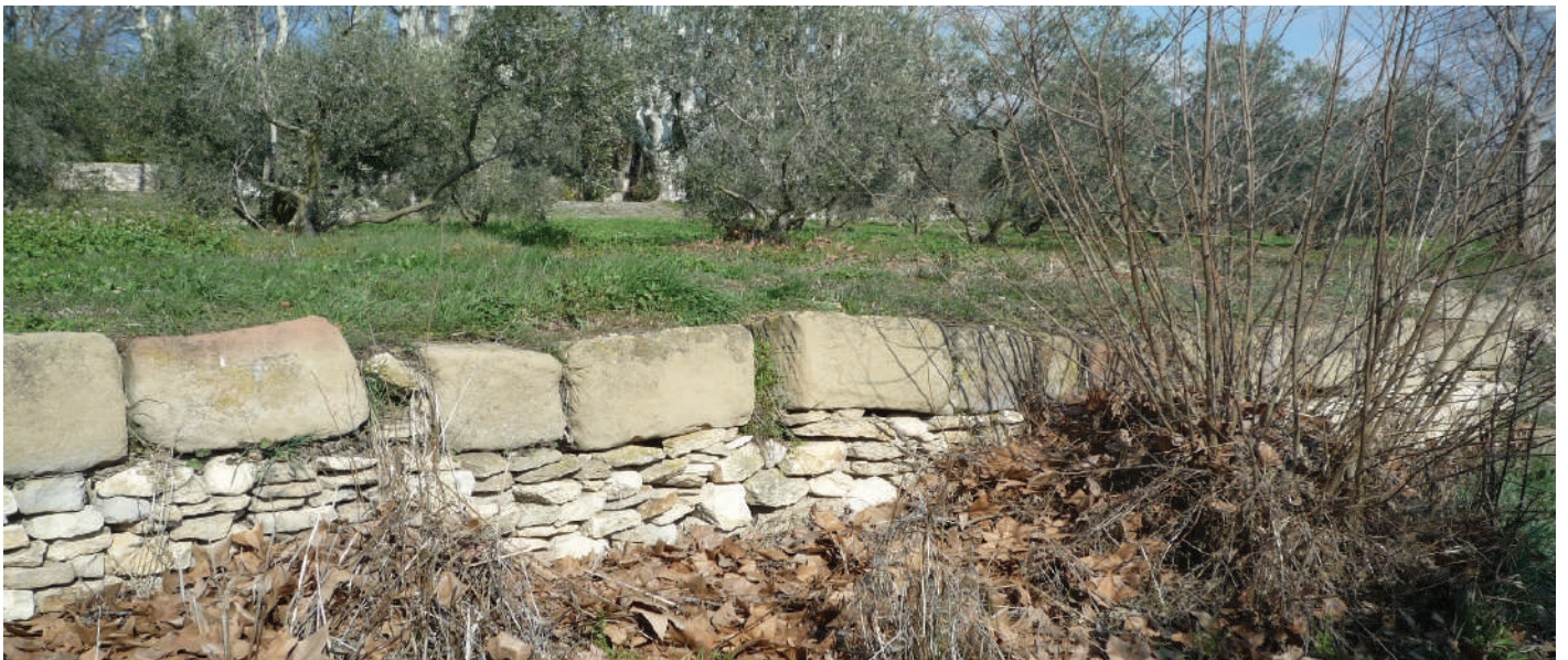
Figure 50 : Les bancaous visibles aujourd'hui sur l'emprise du projet participent d'une gestion de l'eau pluviale dans la pente Source: ATM
