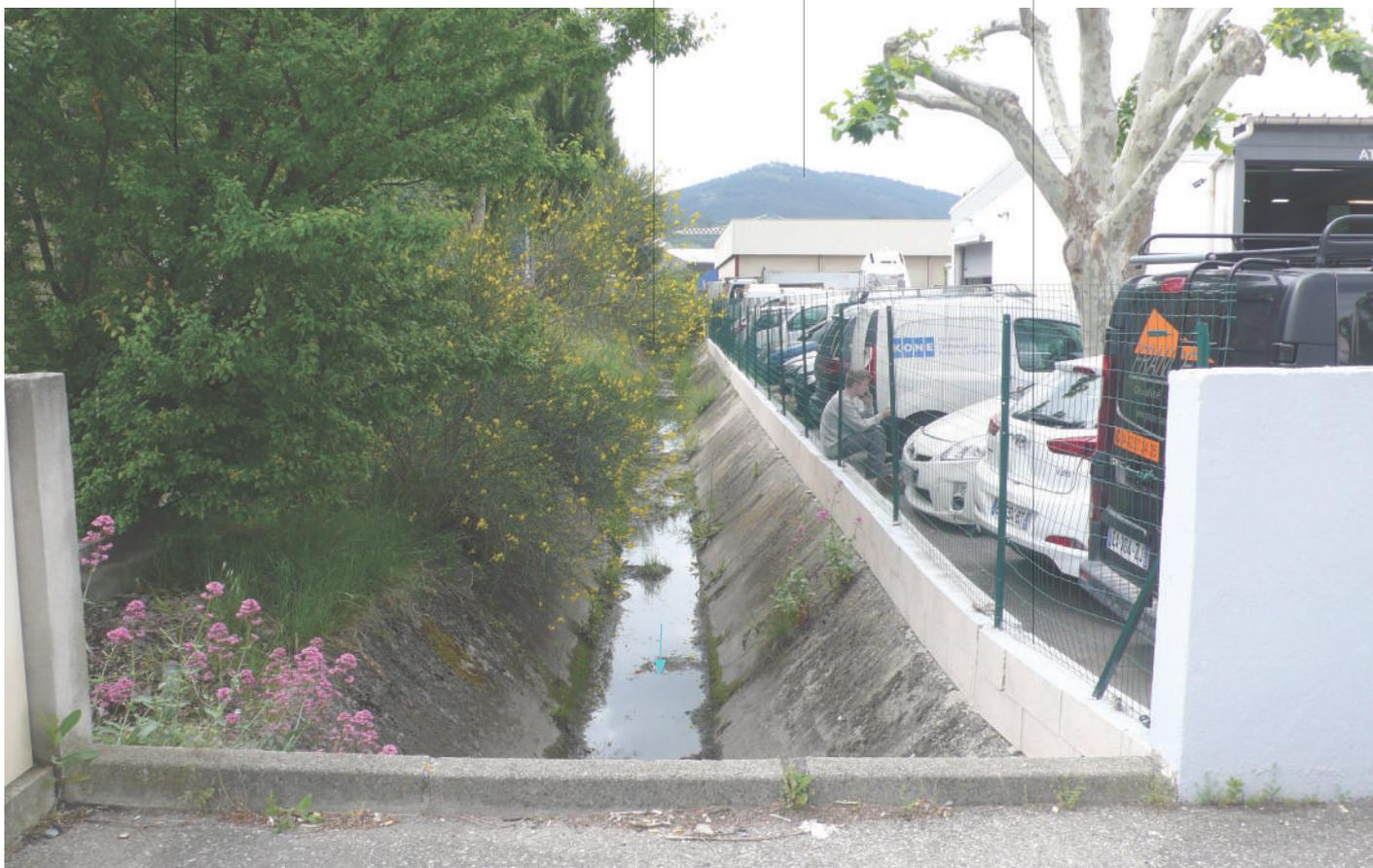
Figure 59 : La servitude permettant l'entretien des trapézoïdaux n'est souvent pas respectée par les entreprises
