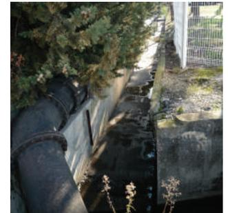
Figure 24 : Canalisation sous pression avec rejet dans la Contre-Maire, refoulement de la station de relevage
