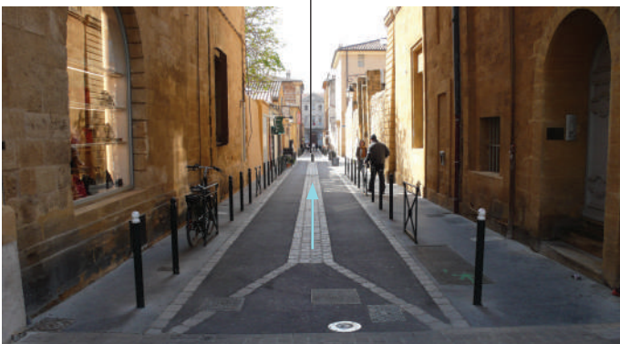
Figure 33 : Fil d'eau dans une rue du centre-ville d'Aix-en-Provence Source : ATM
