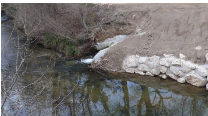
Figure 21 : Une relation ville/rievière qui autorise des ouvrages hydrauliques difficiles à intégrer, exutoire Krypton Source: ATM
