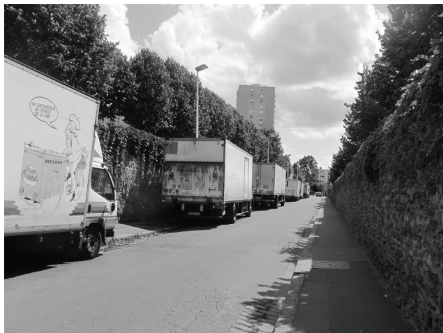
Figure 65 : La photographie de la rue Sœur Valérie avant les travaux montre une monofonctionnalité des espaces, Nanterre Source: ATM
