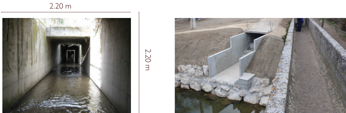
Figure 44 : La galerie Krypton et son exutoire dans la rivière de l'Arc Source: Extrait du diagnostic des réseaux, Schéma directeur et zonage des eaux pluviales d'Aix-en-Provence
