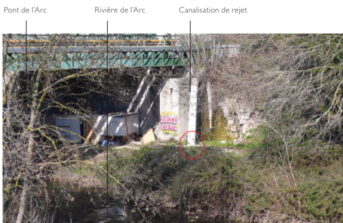
Figure 22 : Un état médiocre de la rivière à la hauteur du Pont de l'Arc Source: ATM
