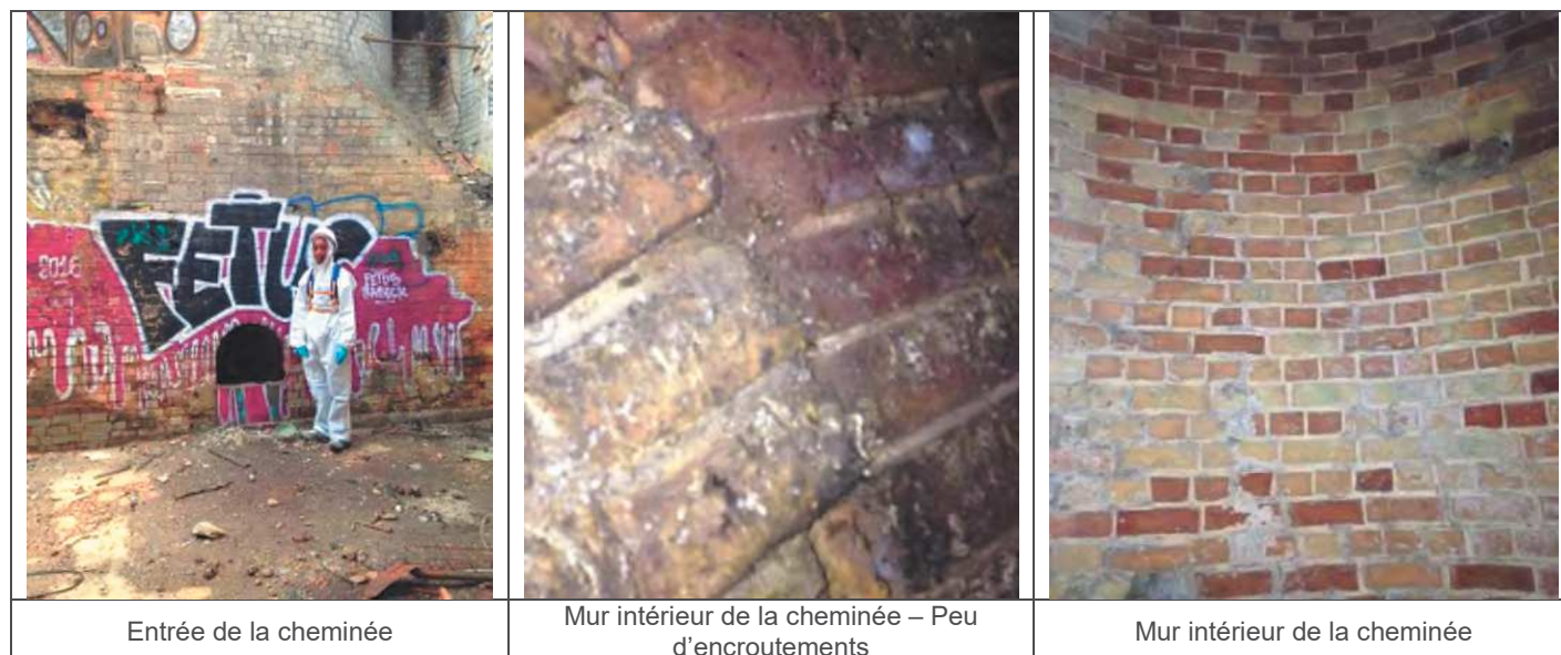
Figure 47: Reportage photographique des investigations réalisées - cheminée verticale sur site
