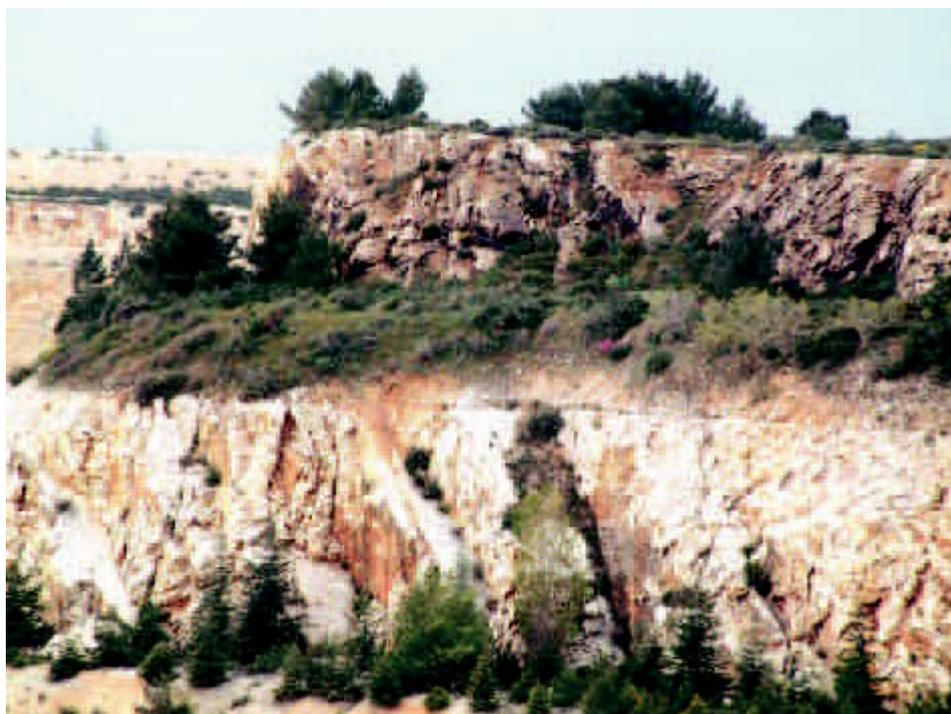
Pour les exploitations en roche massive, les écueils à éviter sont principalement les réaménagements trop typés (caractère linéaire des gradins et banquettes), l'impact visuel important, la trop grande profondeur de l'excavation, la présence de stocks aériens de stériles et d'anciens bâtiments d'exploitation.
