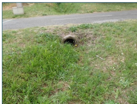
Figure 7 : Buse vue de l'amont
