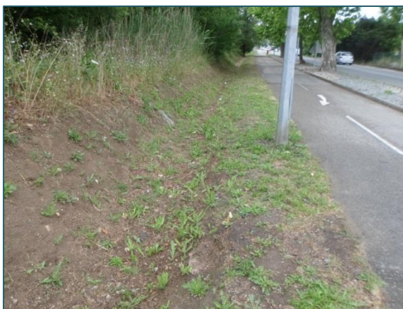
Figure 18 : Fossé longeant la RD 559 à gauche vu de l'amont
