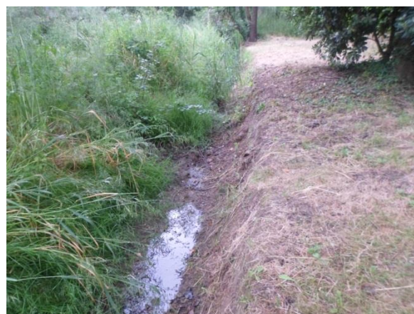
Figure 23 : Fossé Ouest dans le camping
