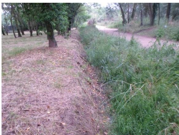
Figure 22 : Fossé Ouest dans le camping
