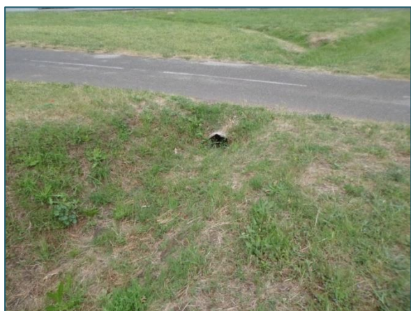
Figure 6 : Buse vue de l'aval
