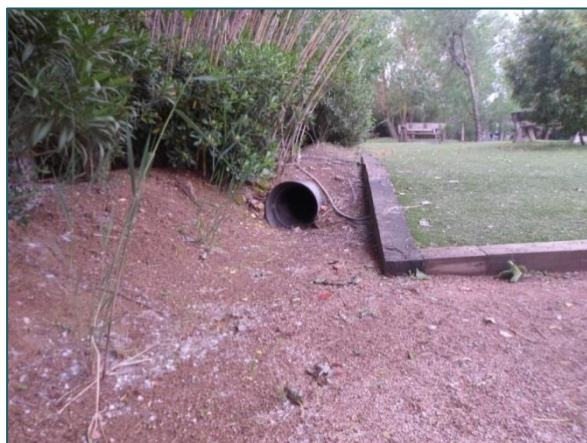
Figure 14 : Entrée de la conduite
