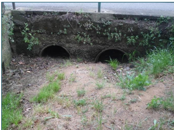
Figure 20 : Buses traversant la RD 559 vues de l'aval
