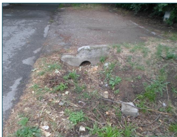
Figure 9 : Fossé et buse \Phi 200 mm provenant du parking
