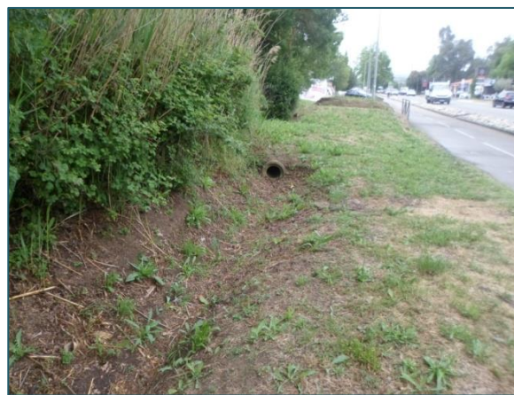
Figure 19 : Buse du fossé longeant la RD 559 à gauche
