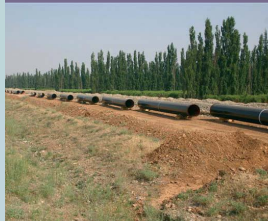
Pipelines : adduction d'eau, oléoduc, gazoduc...
